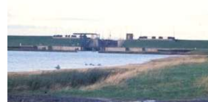
v.m. sluis in buitendijkskanaal
